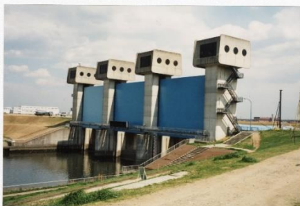
82. 岩淵水門工事8
