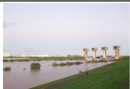
88台風一過1日目の岩淵水門2
