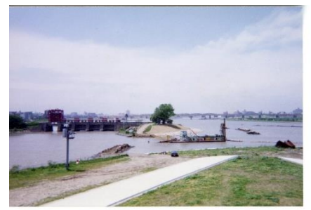
81. 岩淵水門工事7
