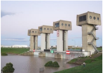
87. 台風一過1日目の岩淵水門1
