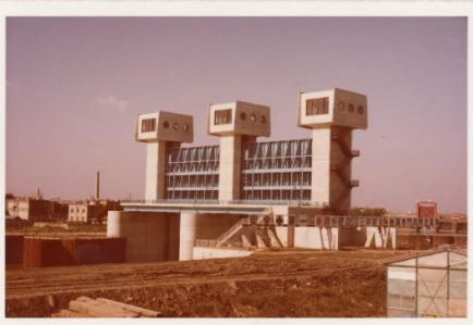
79. 岩淵水門工事5
