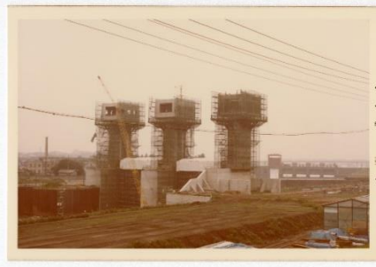
77. 岩淵水門工事3巻上機室の建設
