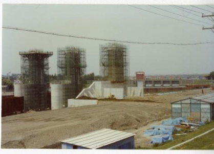
76. 岩淵水門工事2門柱の建設
