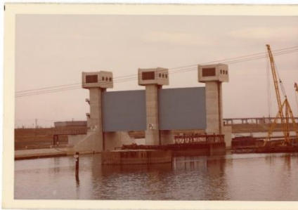
80. 岩淵水門工事6
