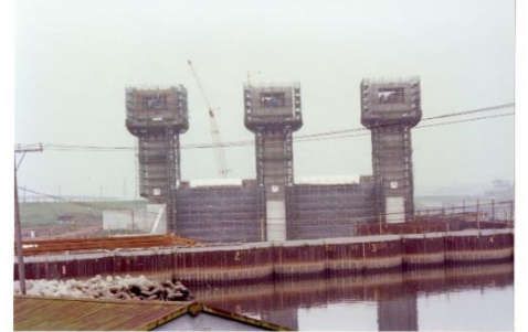
78. 岩淵水門工事4
