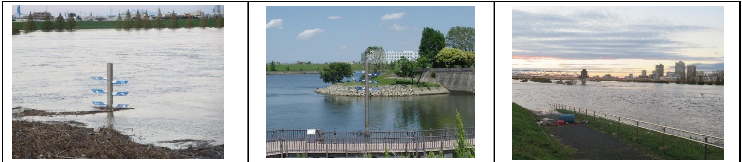
91. 台風一過1日目の水位標柱 令和元年台風第19号 (2019年10月13日撮影) 92. 普段の水位標柱 令和元年台風第19号 (2019年10月13日撮影) 93. 台風一過1日目の新荒川大橋 令和元年台風第19号 (2019年10月13日撮影)
