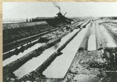
蒸気掘削機による機械掘削の様子
