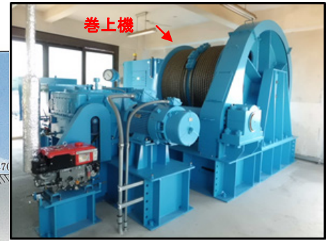
巻上機室の中の様子
