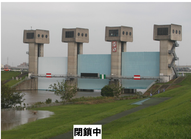
平成 19 年の台風 9 号で岩淵水門を閉めた様子
