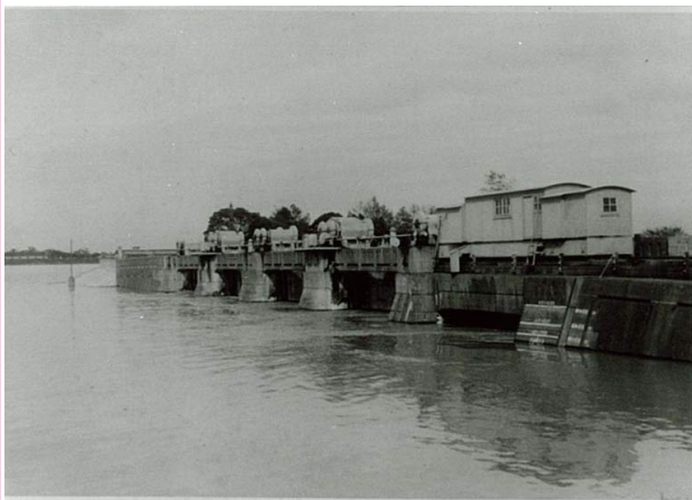
出水につき、水門閉鎖の写真
