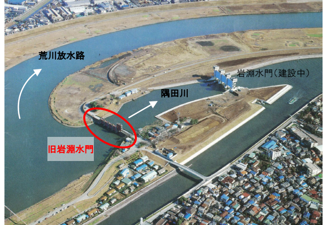
隅田川との分派点の様子(岩淵水門建設中)
