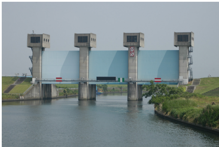
現在の岩淵水門
