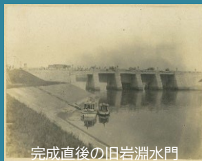
完成直後の旧岩淵水門
